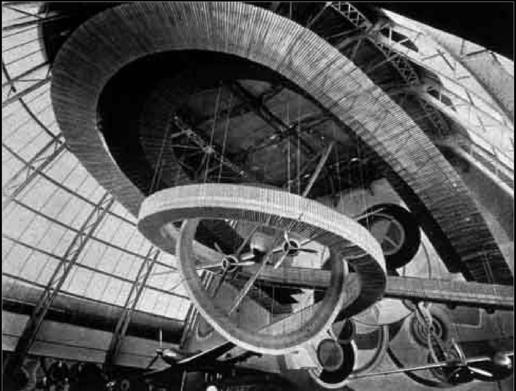
Palais de l'Air Exposition International des Arts et Techniques dans la vie modern
